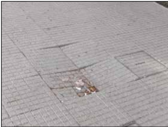
Pavimento intertrabado en mal estado
