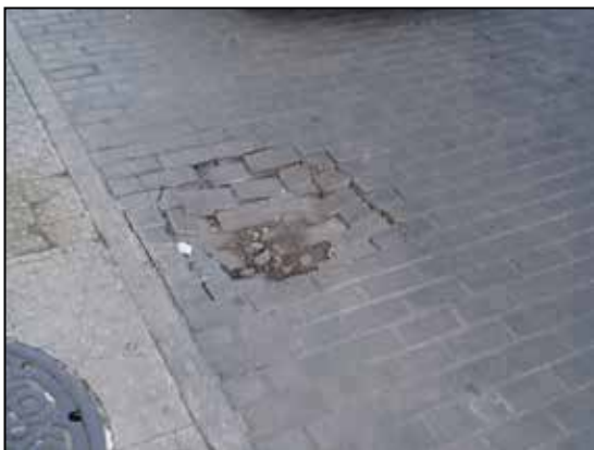
Pavimento intertrabado en mal estado
