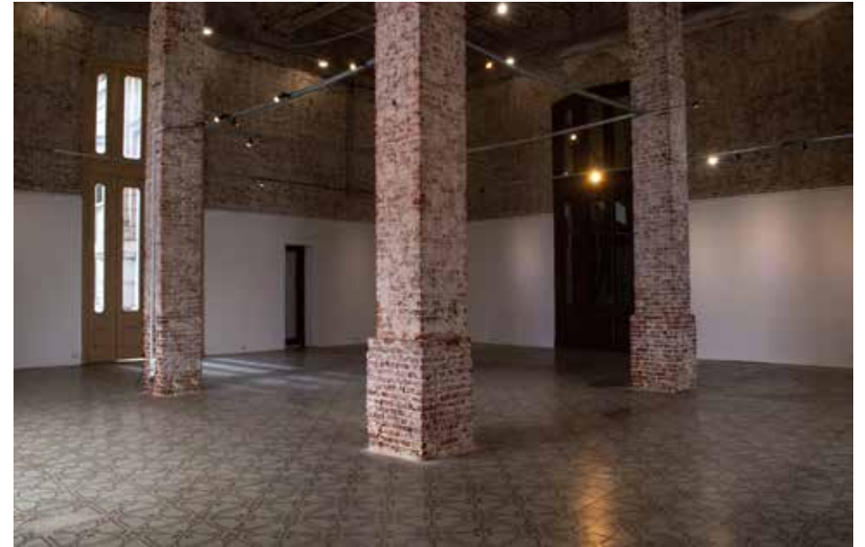
Vista hacia ochava pared Norte (Salida Plazoleta Avellaneda e Ingreso Sec. de Cultura) y pared Este (Ingreso Sala)
