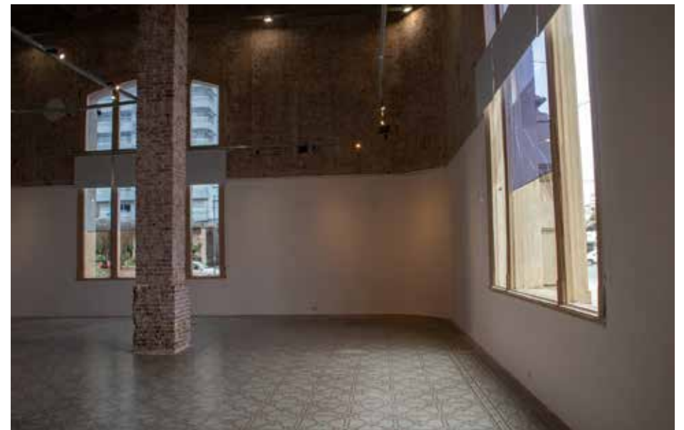
Vista hacia pared Sur (Bulevar Gálvez) sobre lateral pared Oeste (Avellaneda)
