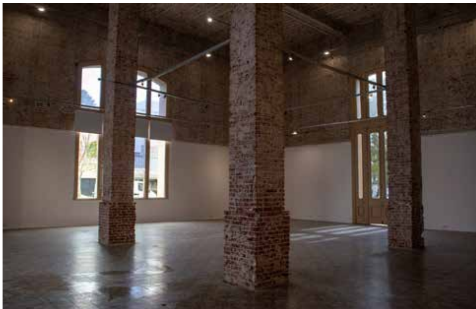
Vista hacia ochava pared Oeste (Avellaneda) y pared Norte (Salida Plazoleta Avellaneda)
