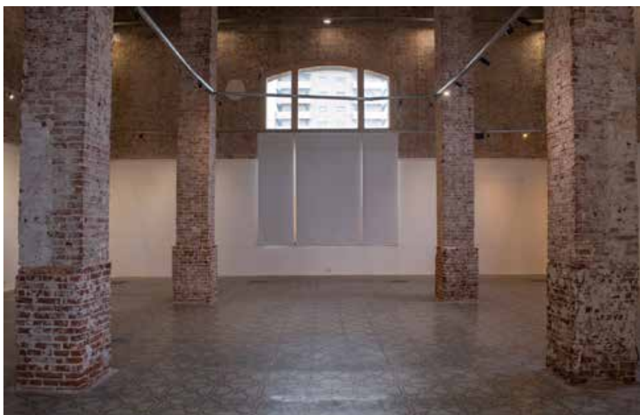
Vista hacia pared Sur (Bulevar Gálvez)
