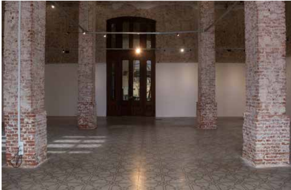
Vista hacia pared Este (Ingreso Sala)
