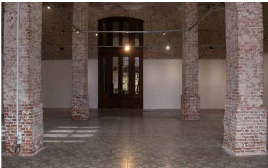
Vista hacia pared Este (Ingreso Sala)
